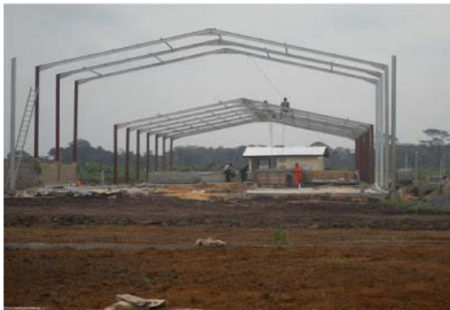
学校の教室建設の様子
